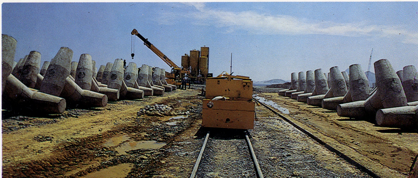
Detalle de los trabajos que ejecuta IPSA en Laguna Verde.
