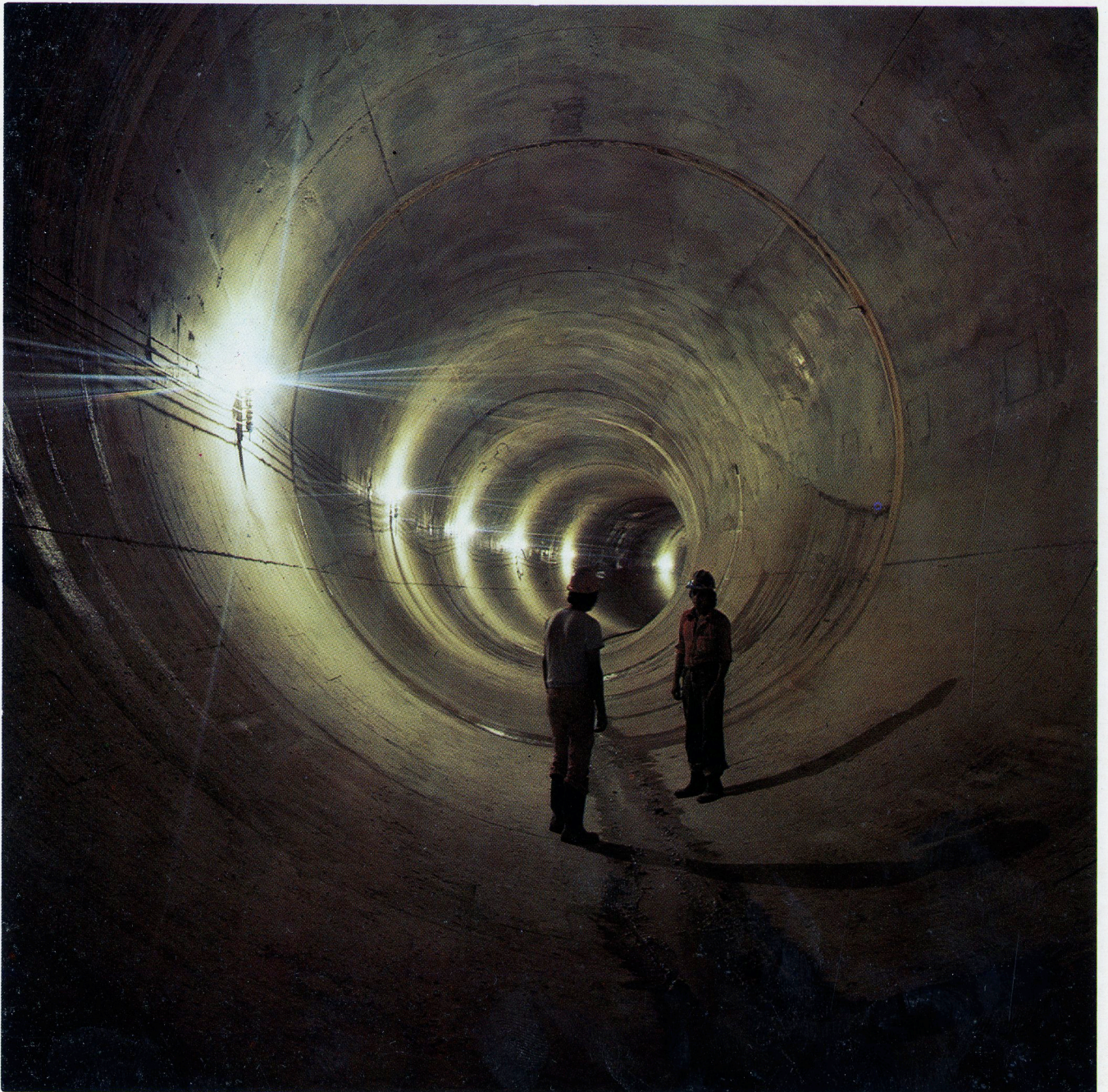
Tramo terminado del túnel de desagüe de emergencia de la Central Hidroeléctrica Chicoasén.
